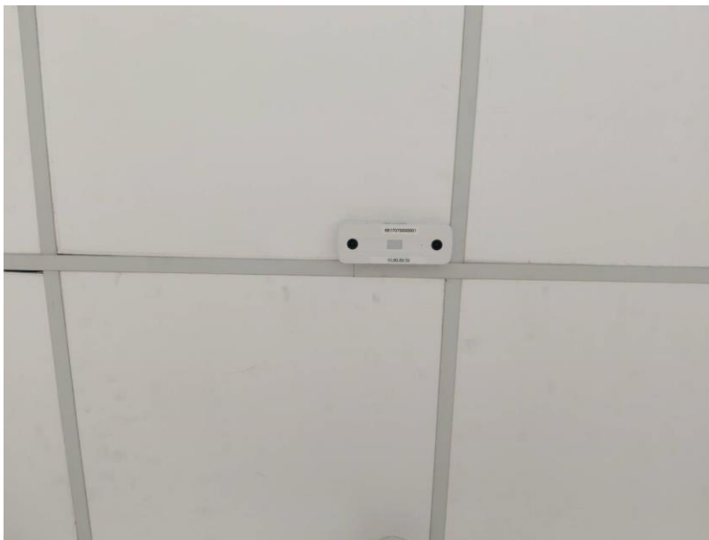
ภาพที่ 4.3 ภาพการติดตั้งกล้อง AI บริเวณเพดาน ประตูทางเข้า-ออกของอาคารศูนย์สารสนเทศ ชั้น 4
