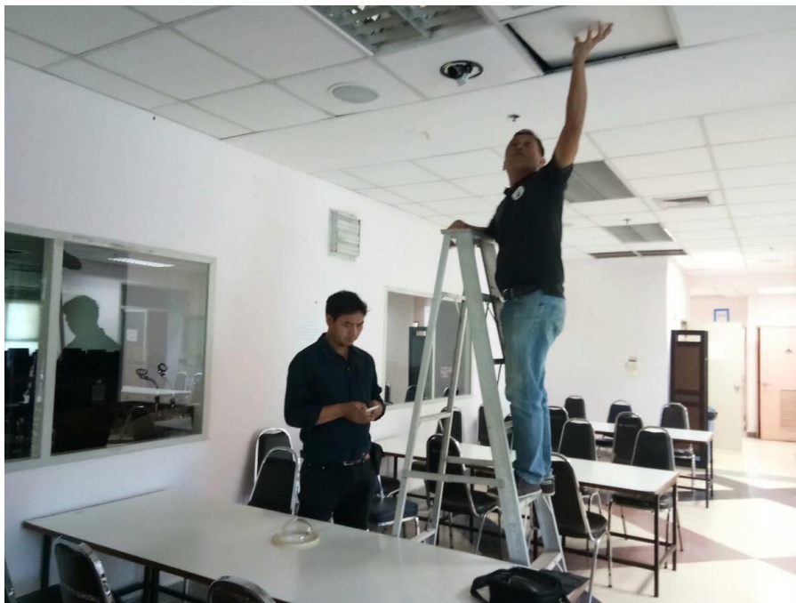
ภาพที่ 3.4 ภาพการดำเนินงานสำรวจจุดติดตั้งกล้อง
