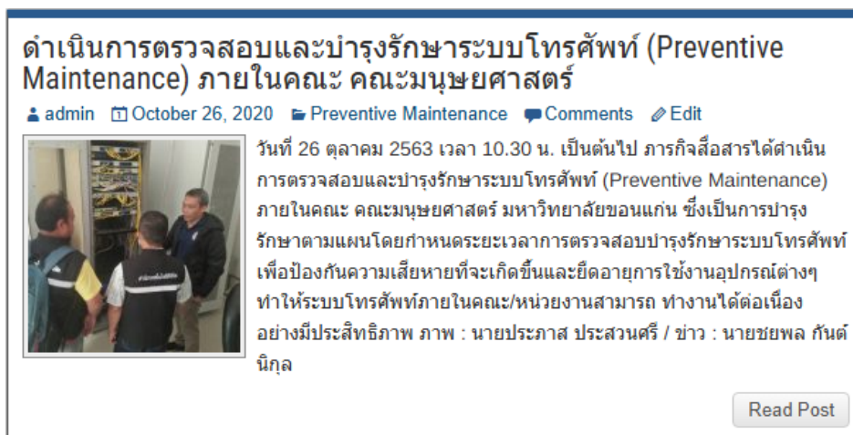
ภาพที่ 4.2 การดำเนินการตรวจสอบและบำรุงรักษาระบบโทรศัพท์ ที่มา https://telecom.kku.ac.th
