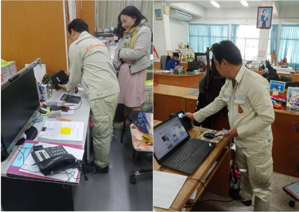
ภาพที่ 3.12 ภาพการซ่อมบำรุงระบบโทรศัพท์ 2
